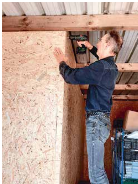
SUP-Lagerschuppen erfolgreich eingebaut!
