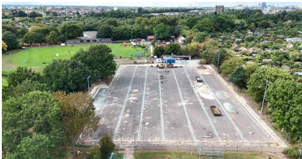
Ein neuer Kunstrasenplatz entsteht auf der Sportanlage Stadtwerder.
