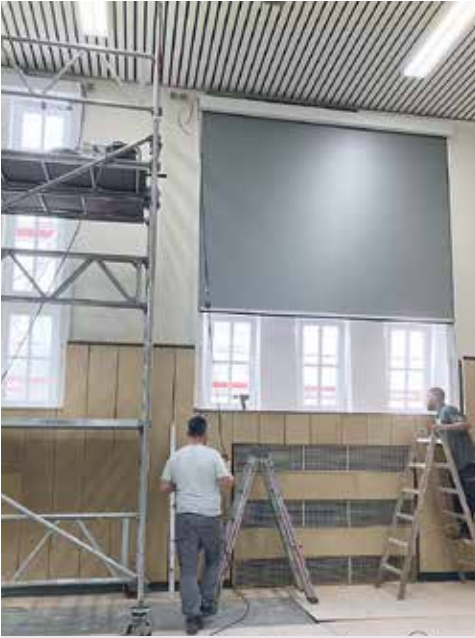
Einbau der Fenster und der Verschattung.
